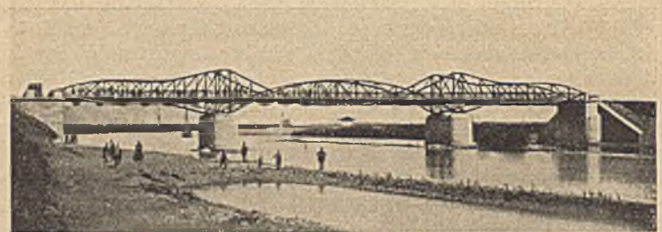
Abb. 6. Straßenbrücke über den Main bei Haßfurt.
