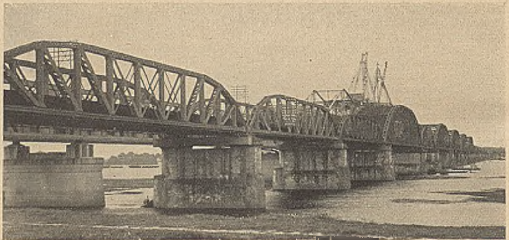
Abb. 5. Alte Eisenbahnbrücke über die Elbe bei Hamerten.
