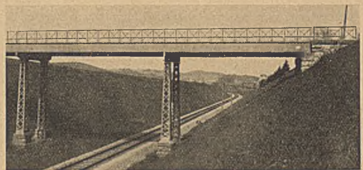
Abb. 3. Feldwegüberführung über die Donaubahn.
