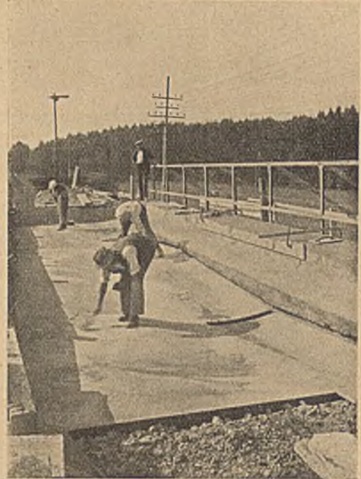
Abb. 5. Aufbringen der Isolierung auf der Brücke bei km 42,273.
