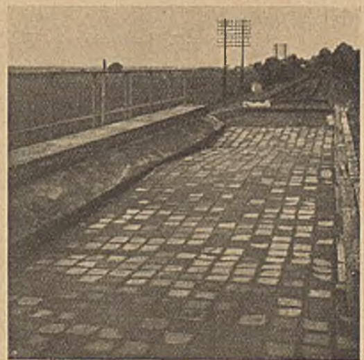
Abb. 6. Blick auf die Schutzschicht über der Isolierung.
