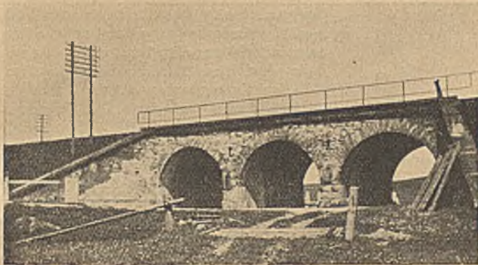
Abb. 4. Ansicht der Brücke bei km 41,416 vor Inangriffnahme der Arbeiten.
