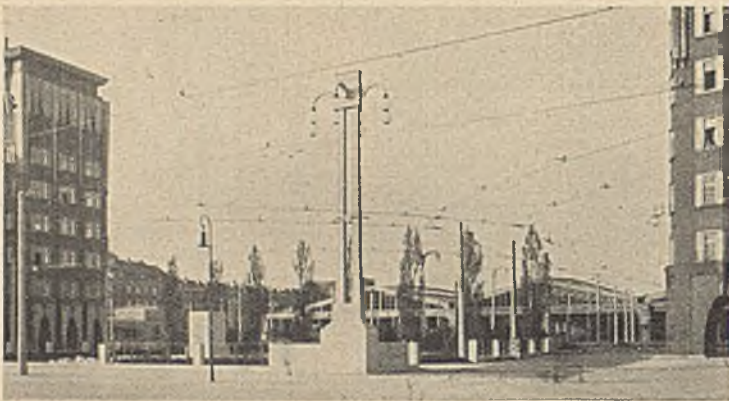
Abb. 3. Einfahrt an der Müllerstraße.
