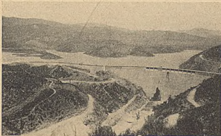
Abb. 1 a. Die St. Francis-Sperre 1 Jahr nach Fertigstellung.
