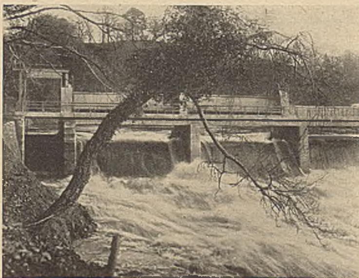
Abb. 4. Obergewichtsklappe in der Clyde (Schottland) von Ransomes & Rapier Ltd. (London).
