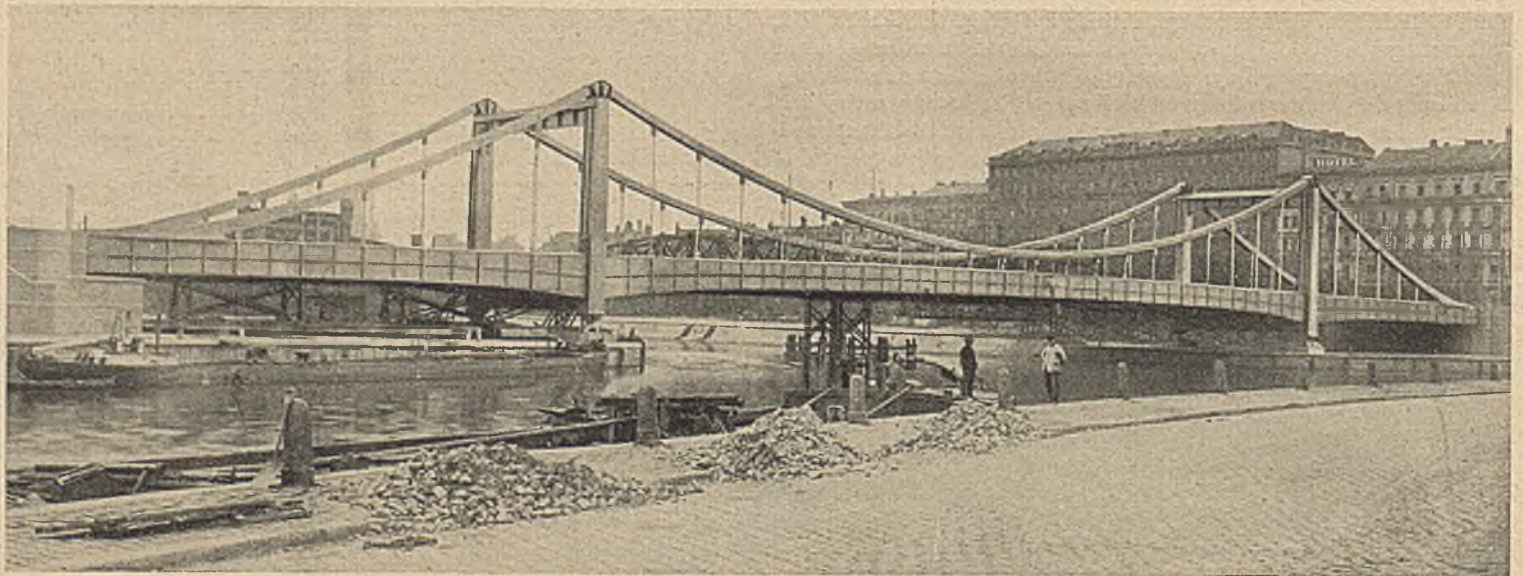
Abb. 8. Gesamt-Ansicht der neuen Hafen-Einfahrt mit Straßen-Überführung.
