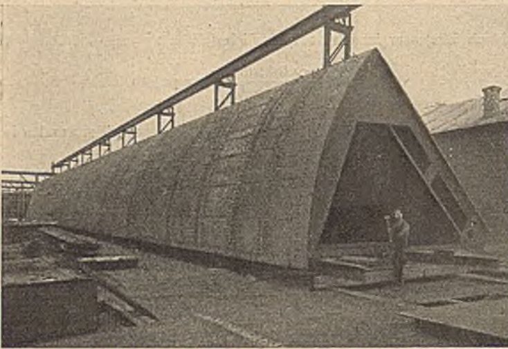
Abb. 21. Sektorwehranlage Raanaasfos (Norwegen) in Werkstattmontage. (Ausführung Maschinenfabrik Augsburg-Nürnberg.)
