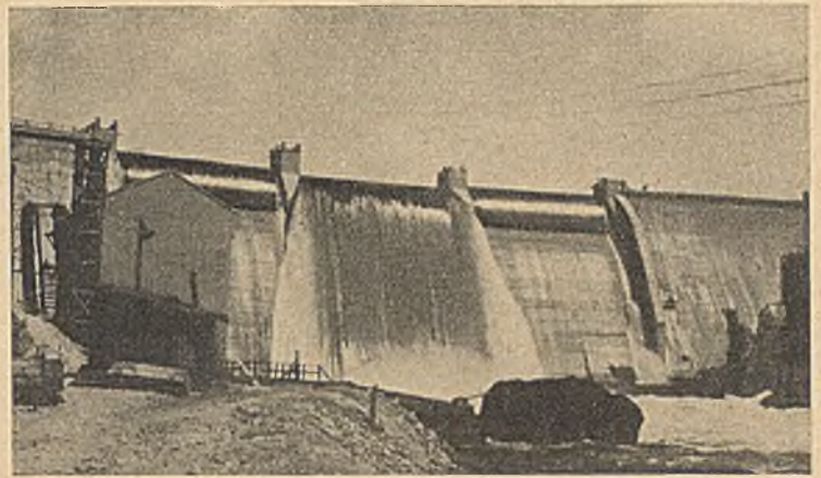
Abb. 26. Die Sektorwehranlage der Black Canyon Talsperre, teilweise überströmt.
