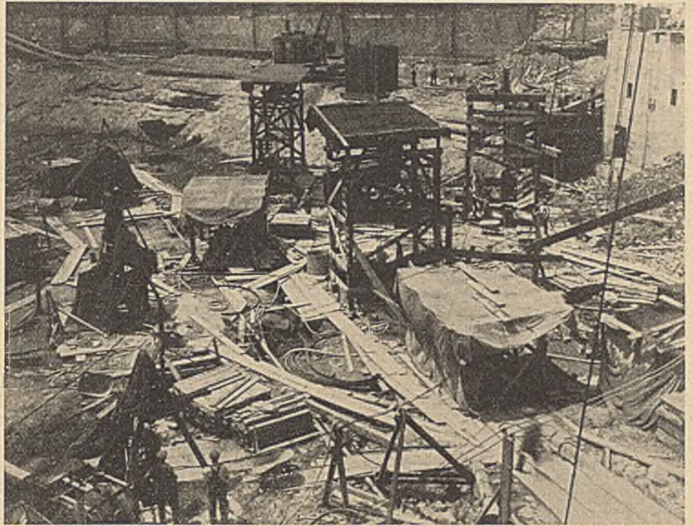
Abb. 4. Überdachung der Brunnen.
