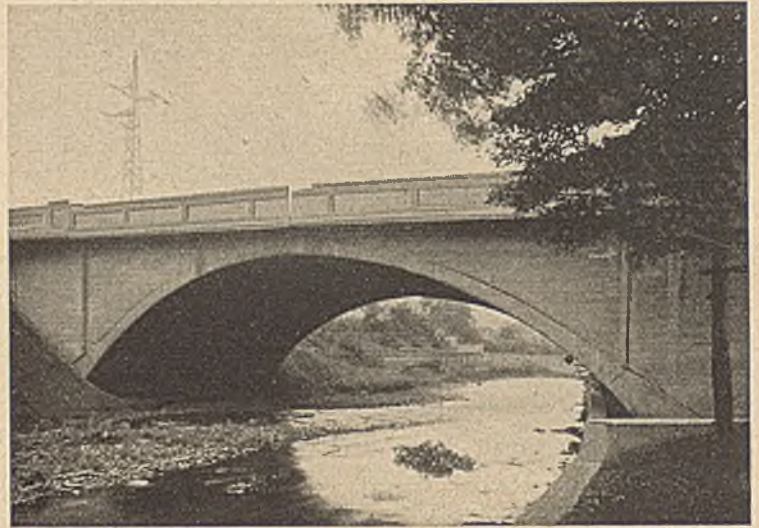
Abb. 2. Zusammenbruch der alten Brücke.
