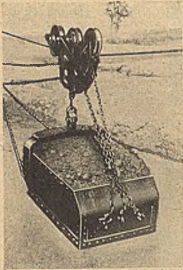
Abb. 7. Eimer für Kabelbagger.
