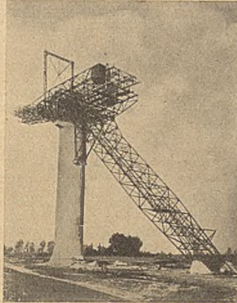
Abb. 15. Haldeturm auf Niederl. Staatsgrube Mauritz.
