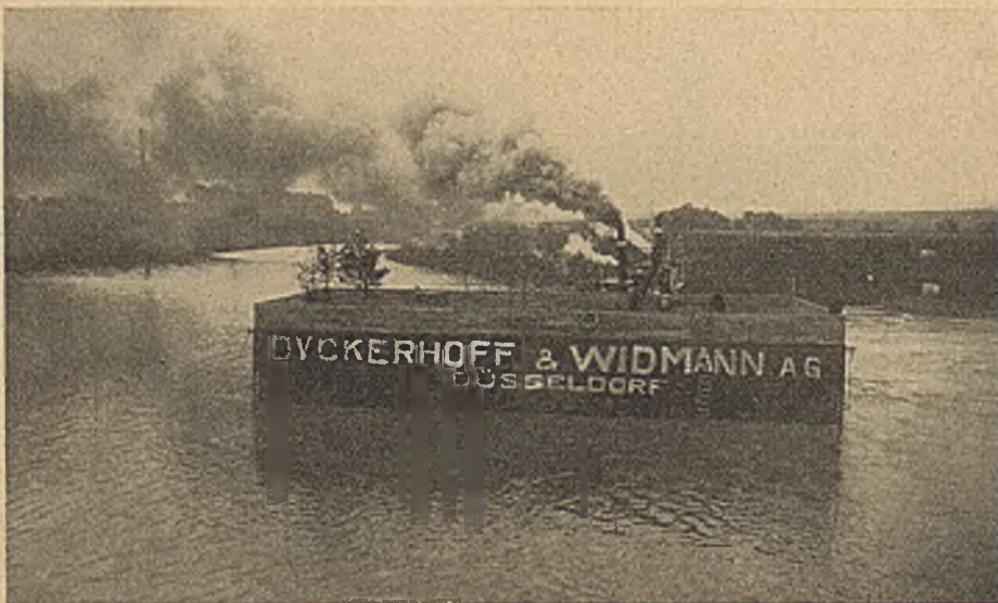
Abb. 5. Rheinbrücke Duisburg—Hochfeld. Der fertiggestellte und vom Helling abgelassene Caisson des Strompfeilers II.
