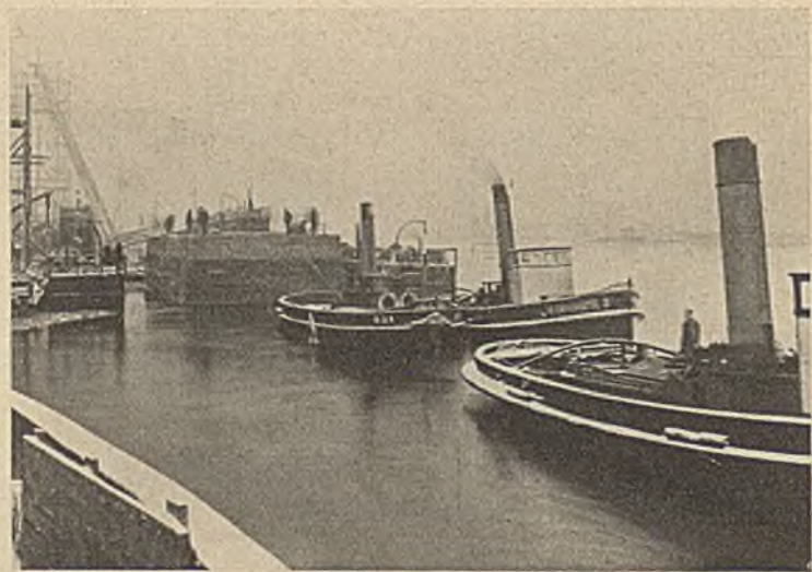
Abb. 11. Ostoderbrücke Stettin, Ausschwimmen eines Caissons aus dem Schwimmdock.
