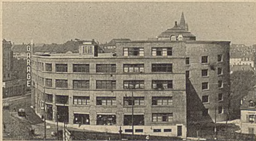
Abb. 2. Seitenfassade mit Fahrtrium.
