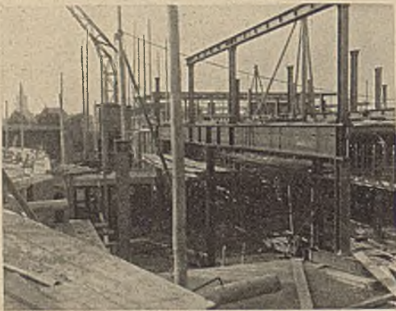
Abb. 13. Eisenkonstruktion über der Vorhalle im Erdgeschoß.
