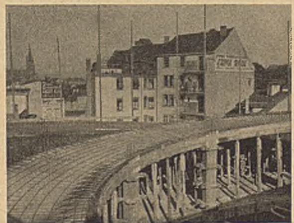
Abb. 10. Konstruktion im Erdgeschoß mit Fahrturm im Vordergrund.
