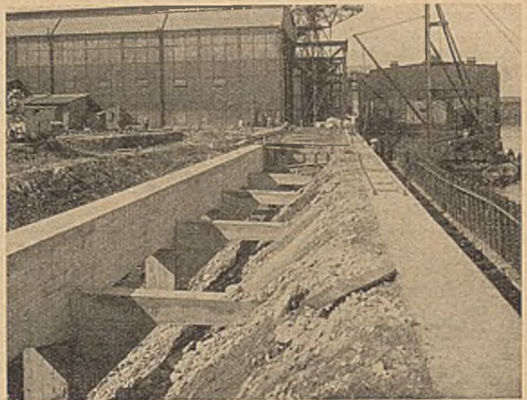
Abb. 9. Landseitige Kranbahn aus Eisenbeton.
