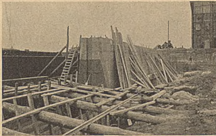
Abb. 7. Ausbildung der Dehnungsfuge.
