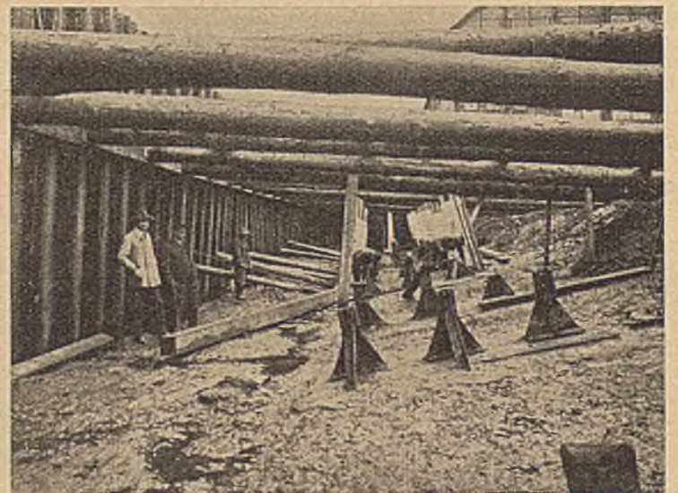
Abb. 5. Baugrube nach der Absenkung des Wassers.
