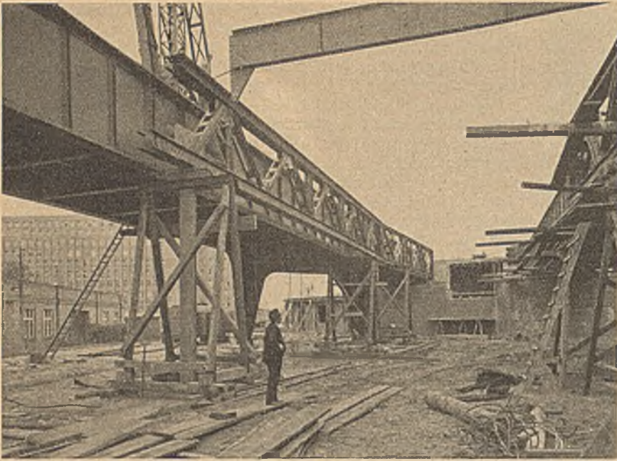
Abb. 31. Bahnhof Siemensstadt. Einbau der Bahnsteigtragkonstruktion zwischen den Gleisstragkonstruktionen.
