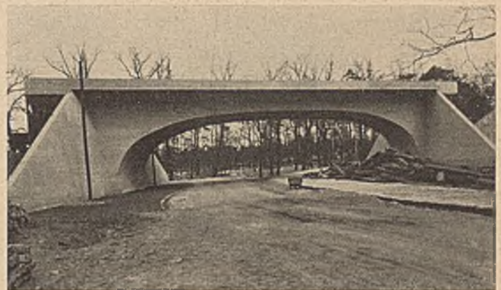
Abb. 30. Eisenbeton-Zweigelenkrahmenbrücke über die verlängerte Brunnenstraße.
