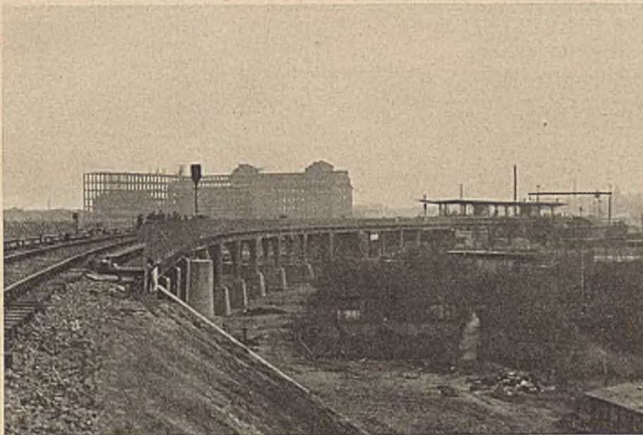
Abb. 29. Viaduktstrecke vom Holztdamm bis Bahnhof Wernerwerk, im Hintergrund der Erweiterungsbau des Rundfunkwerkes der Siemens & Halske A. G.
