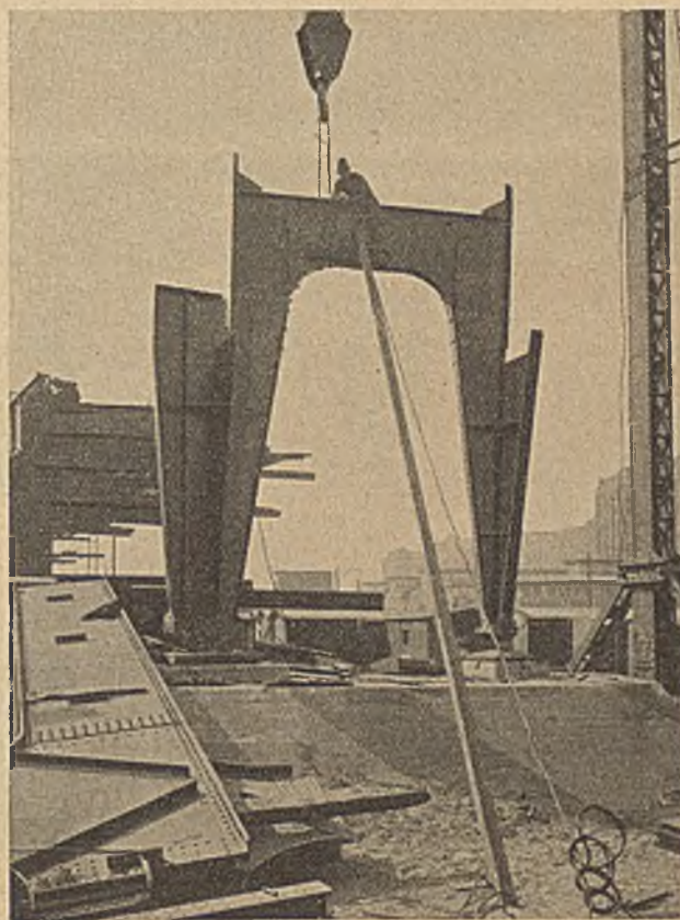
Abb. 23. Bahnhof „Wernerwerk“. Aufstellen eines Portales, links oben Konsol für die Auflagerung des Bahnsteighauptträgers links unten Doppelpunktlager.
