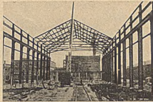
Abb. 1. Geschweißtes Fabrikgebäude während der Aufstellung.
