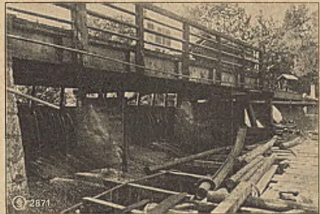
Abb. 2. Teilansicht des alten Wehres.
