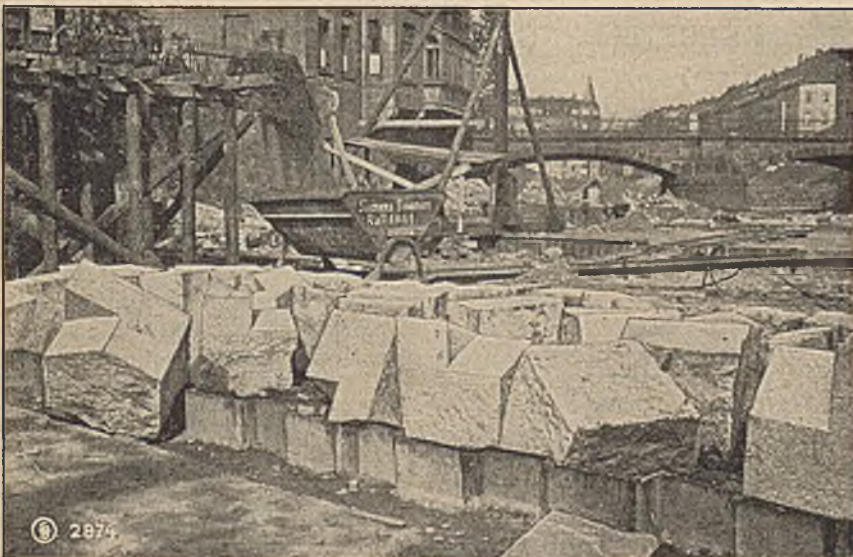
Abb. 6. Granitsteine für die Rehbocksche Zahnschwelle vor der Verlegung.
