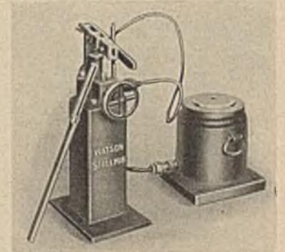
Abb. 7. Hydraulische Presse für Unterfangungen.
