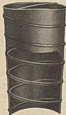
Abb. 5. Eisenblech-Rohr des Raymond-Pfahls
