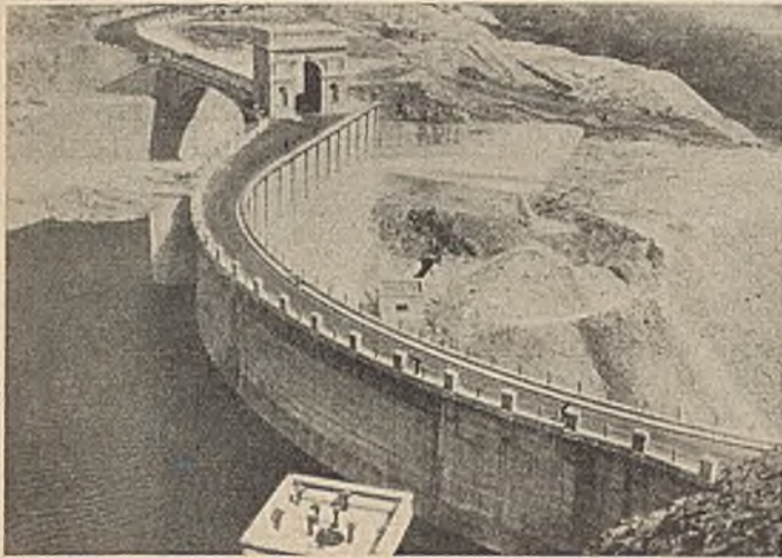
Abb. 2. Talsperre Hartebeestport bei Pretoria.
