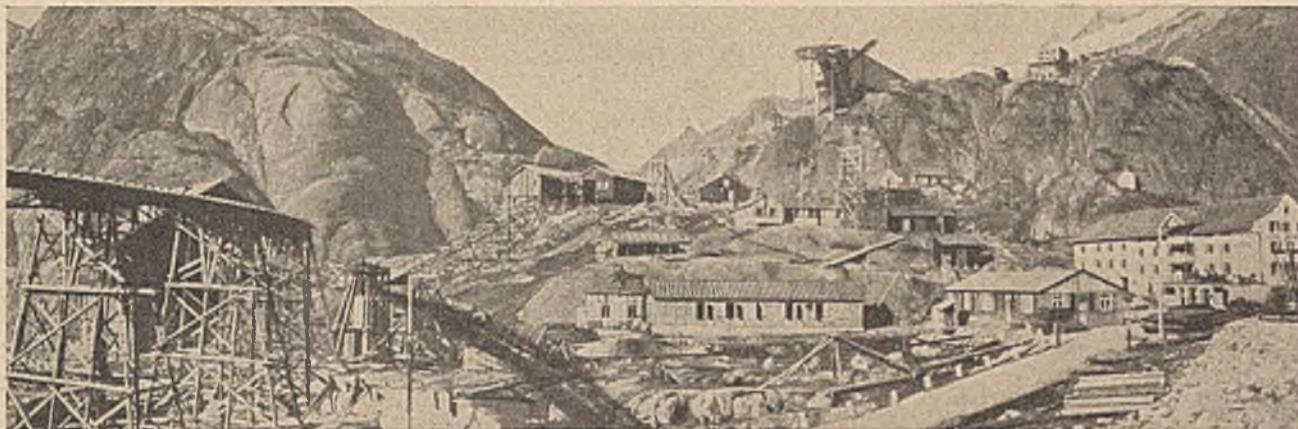
Abb. 7. Aufbereitungs- und Betonmischanlagen auf dem Nollen. — Mittelpunkt der Bauarbeiten, Endpunkt der Ferndrahtseilbahn, Ausgangspunkt der Betonverteilung. (Rechts das hinausragende Band zur Aufschüttung der Reserve-Kieshalde.)
