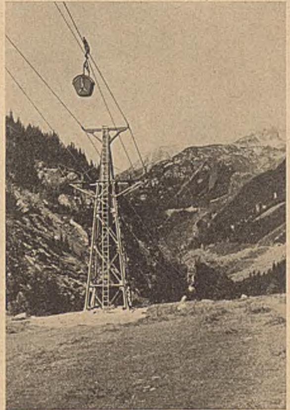
Abb. 3. Ferndrahtseilbahn (Bleichert) von 17 km Länge zwischen Innertkirchen und Grimselospiz zur Baustoffzufuhr. (Gesamtsteigung rd. 1200 m, Wagenkasten mit Verschlussdeckel zum Zementtransport.
