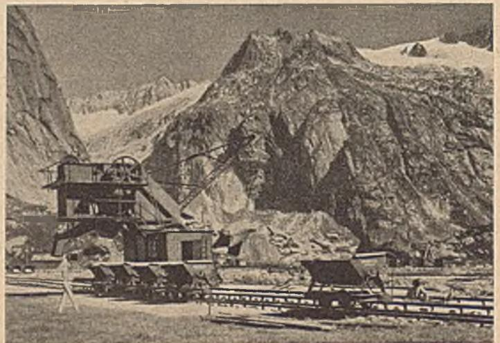
Abb. 6. Lübecker Eimerkettenbagger bei der Sandgewinnung im Aarboden.
