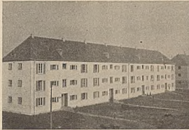
Abb. 1. Holzfachwerkhaus (Siedlung Hallschlag bei Stuttgart) mit fabrikmäßig hergestellten Holzrahmen. Entwurf: Prof. Paul Schmitthenner.
