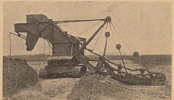
Abb. 1. Eimerkettenbagger für Leistungen bis 37 m 3 /h.
