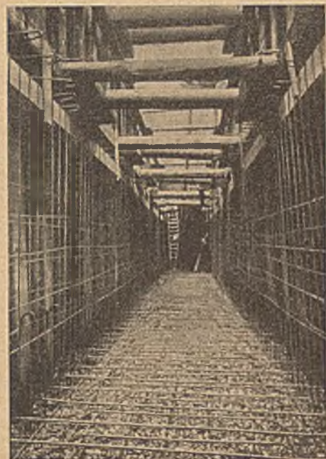
Abb. 11. Praktisch wasserdichte Baugrube auf eine Schottlänge von 50 m, gut im Schloß gebliebene Larssenwände, wasserdichte Versteinerung unter der Kanalsohle, auf der Drainage eingelegte Sohlenarmierung und Armierung der Kanalwände, etwa 10 l/s Wasserhaltung bei 3,50 m Grundwasserstand über der Sohle.
