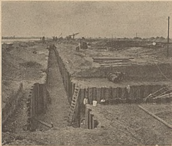
Abb. 5. Fertig mit Larssenspundwand umschlagene auf Cote + 3,00 und + 2,50 m am Ortspegel ausgehobene Baugrube mit Eckbauwerk.
