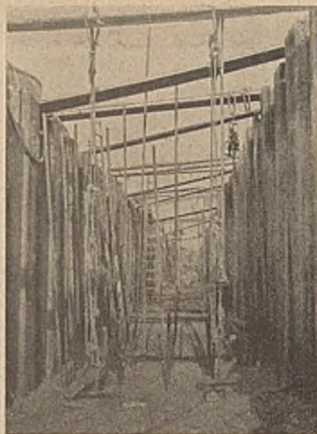
Abb. 6. Große Anzahl von Einspritzrohren in gegenseitigen Längs- und Querabständen voneinander von je etwa 75 cm in einem Bauabschnitt.
