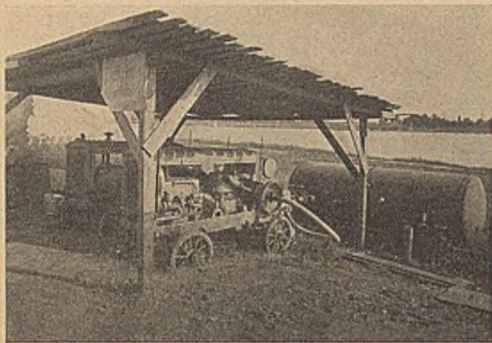
Abb. 8. Die Luftkompressoren-Anlage zur Lieferung der Preßluft bis zu 15 Atm. für die gesamten Bodenverfestigungsarbeiten.
