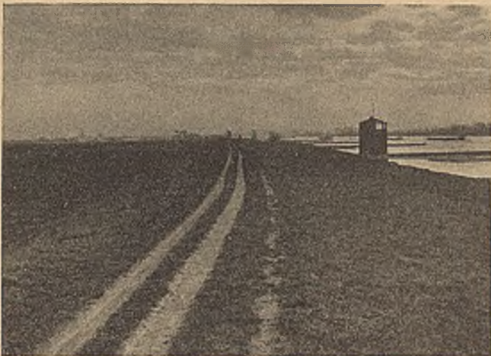
Abb. 3. Das hochgelegene Außendeichgelände, Baustelle für die Wassergewinnungsanlage vor Beginn der Arbeit.
