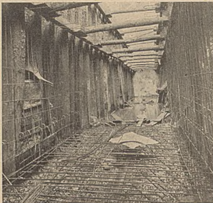
Abb. 12. Schott mit aus dem Schloß gesprungenen Spundwänden.
