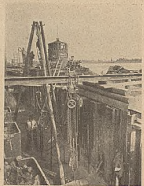
Abb. 7. Versteinungsarbeiten, Schlagen der Spritzrohre mit Preßluft-Rammbar, Einspritzen des Chemikals I beim Eintreiben, des Chemikals II beim Ziehen der Spritzrohre mit Flaschenzug. Im Hintergrund der alte Rheinturm.
