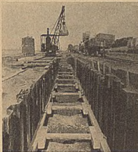
Abb. 10. Erster Rahmenverbau zwischen den Larssenwänden in etwa 2,30 m Tiefe. Im Hintergrund der alte Rheinturm, an dem das Entlüftungsrohr für den Heberkanal hochführt.
