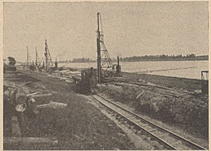
Abb. 16. Umschlagen der Heberrohrkanal- und Brunnen-schachtbaugrube mit Larsseneisen und Dampfkrannen.
