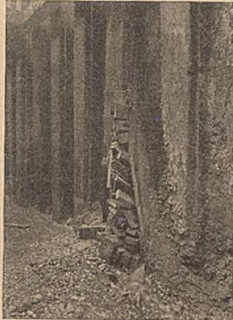
Abb. 14. Aus dem Schloß gesprungene Spundwände, die mit Holzklotzen und Beton abgedichtet wurden.
