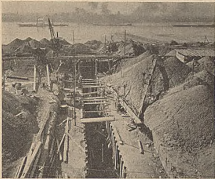
Abb. 19. Blick vom Sammelbrunnen auf die Baugrube des Heberrohrkanal-Endstückes und den durchbrochenen Deich mit Schutzspundquervand.
