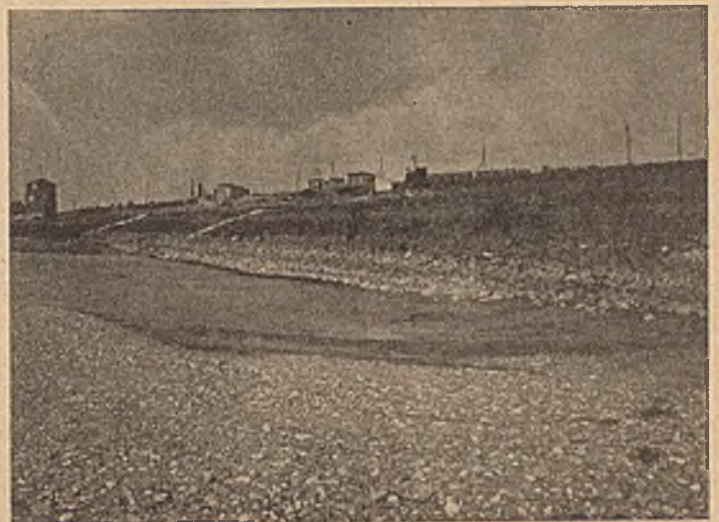
Abb. 15. Geringe Wasserhaltung in den einzelnen Schotten, Ansicht vom Rhein auf zwei Einlaufstellen.
