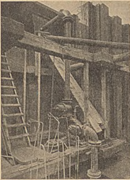
Abb. 13. Wasserhaltung mit etwa 10 l/s in einem Schott von 50 m Länge.
