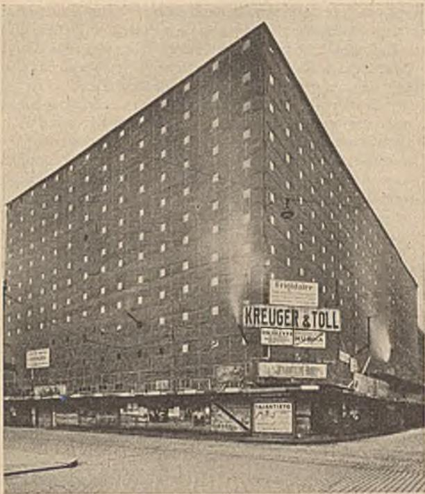
Abb. 26. Wie 27. Bau mit Winterverkleidung während der Ausführung. Das Gebäude steht auf 12—20 m hohem Pfahlrost.
