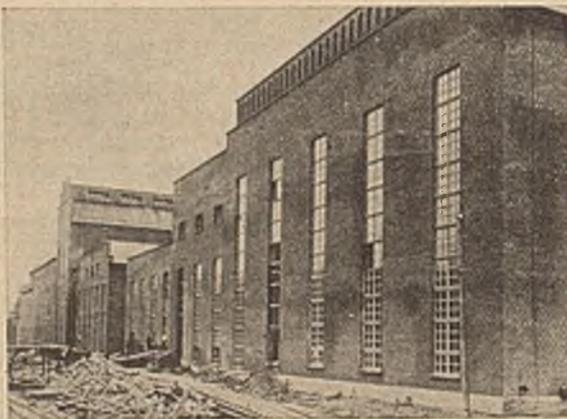
Abb. 23. Wie 22. Straßenansicht der Eisenbetonskelettbauten mit Ziegelverkleidung.
