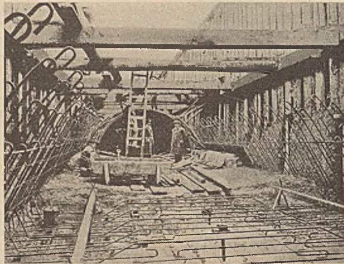
Abb. 6. Ausführung des Eisenbetonkanals der Uferstrecke in offener Baugrube zwischen Larssenspundwänden.
