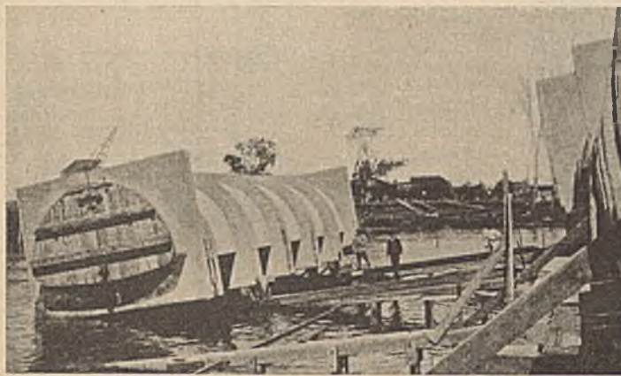
Abb. 9. Eisenbetonrohr von 15 m Länge mit provisorischen Abschlußdeckeln.
