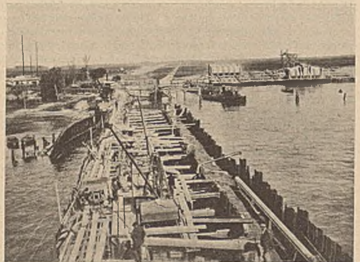
Abb. 7. Ausführung des Endstückes der Uferstrecke zwischen aus Larsseneisen gebildeten Fangdämmen.
