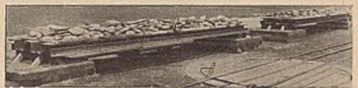
Abb. 5. Durchbiegungs-Versuche mit 4 Bohlen K III.
