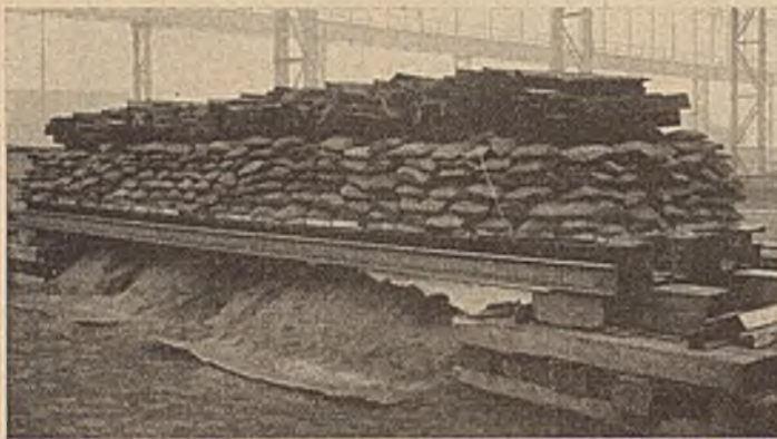
Abb. 6. Belastung von 4 Bohlen K III mit P = 40,4 t.
