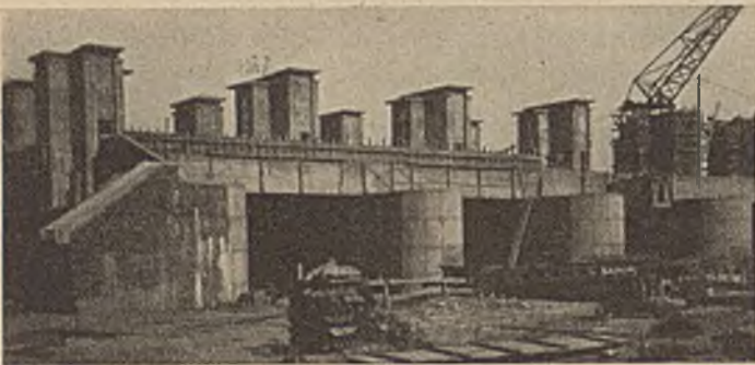
Abb. 6. Entwässerungsschleusen bei Wieringen im Hauptdamm. Ostgruppe fertig.
