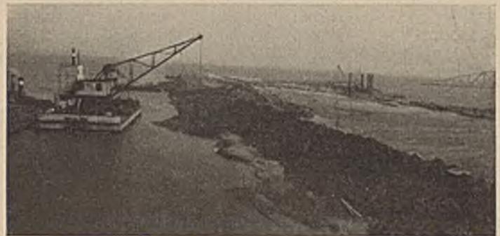
Abb. 4. Bauvorgang bei Herstellung des Damms (Spülung) und Kaileemeinbau.
