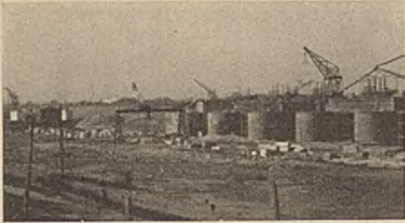
Abb. 5. Entwässerungsschleusen bei Wieringen. Westgruppe im Bau.
