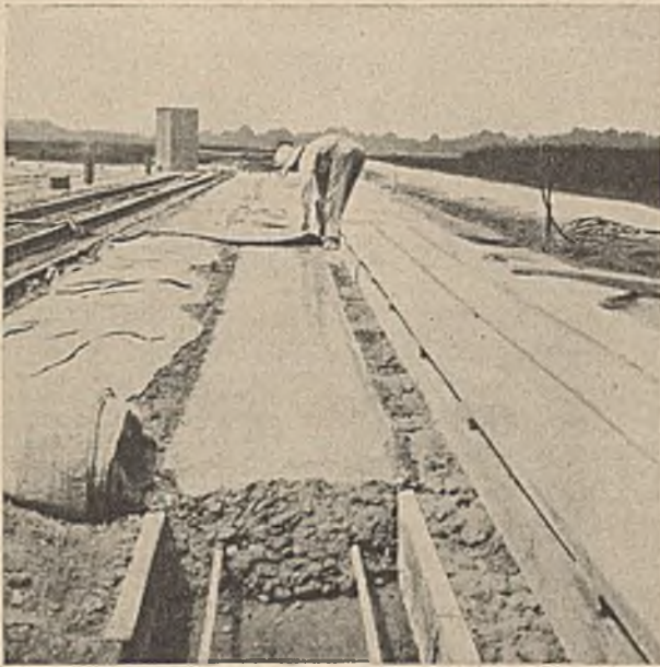
Abb. 1. Auflegen von feuchten Zeltplanen auf die frisch hergestellten Betonplatten.
