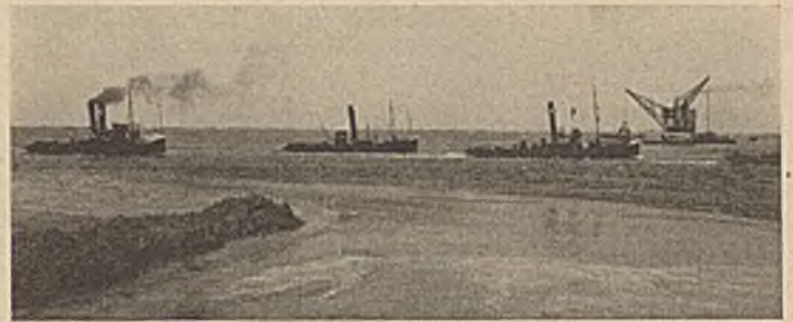
Abb. 7. Schließung des Deiches im Wieringermeer-(N.W.)-Polder.
