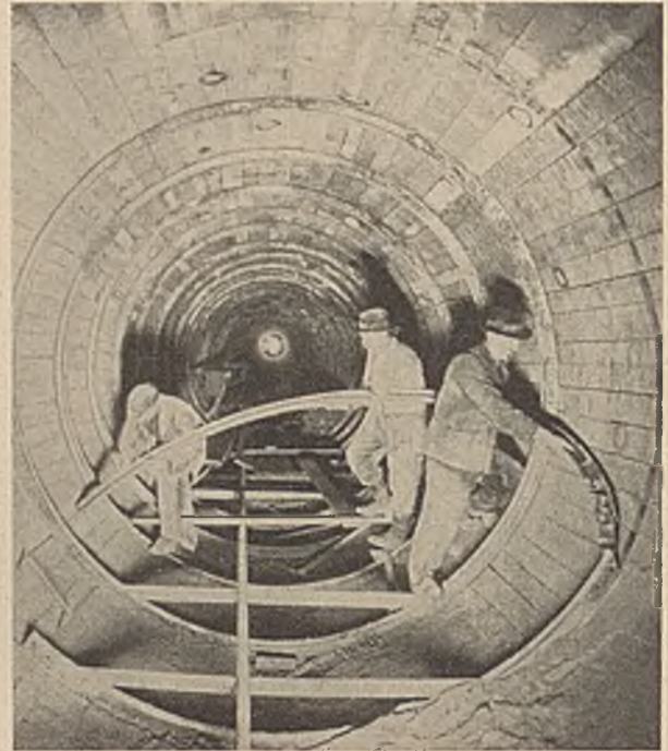
Abb. 16. Schalung beim Schwarzenbachstollen.
