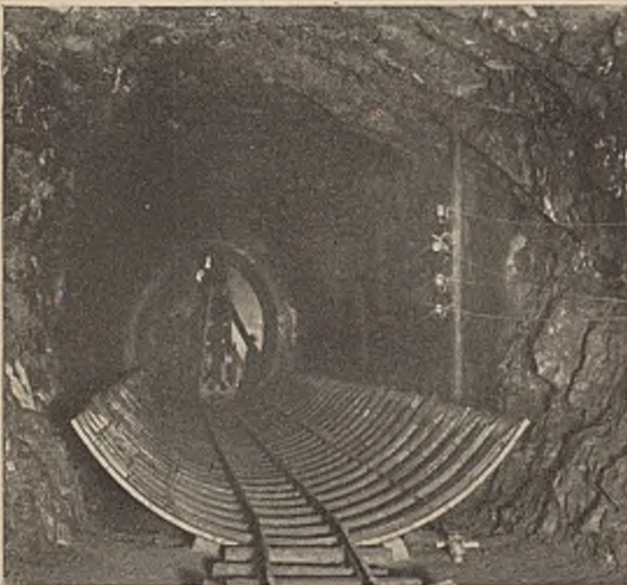
Abb. 18. Schalung im unteren Stollenteil.
