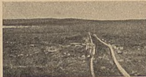
Abb. 6. Einfluß von Frosterhebungen und „Frostschub“ im Erdreich auf eine Gleisanlage in Alaska.
