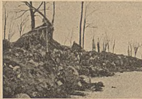
Abb. 5. Von der Schubkraft des Eises aufgeworfener Damm.
