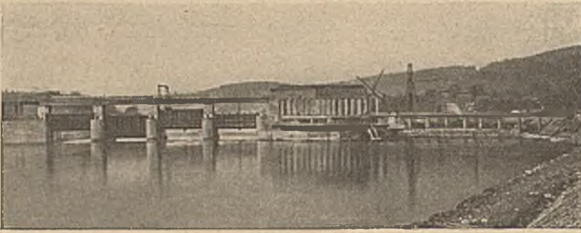
Abb. 3. Blick auf die Anlage von Oberwasser.
