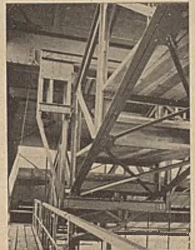
Abb. 22. Untersuchungswagen: Blick von Süden auf Wagen, Aufhängung und Lagerung der Laufbrücke.
