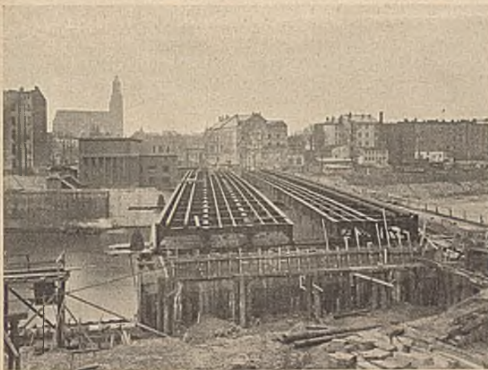
Abb. 8. Blick auf das Tragwerk vor dem Zusammenschluß.
