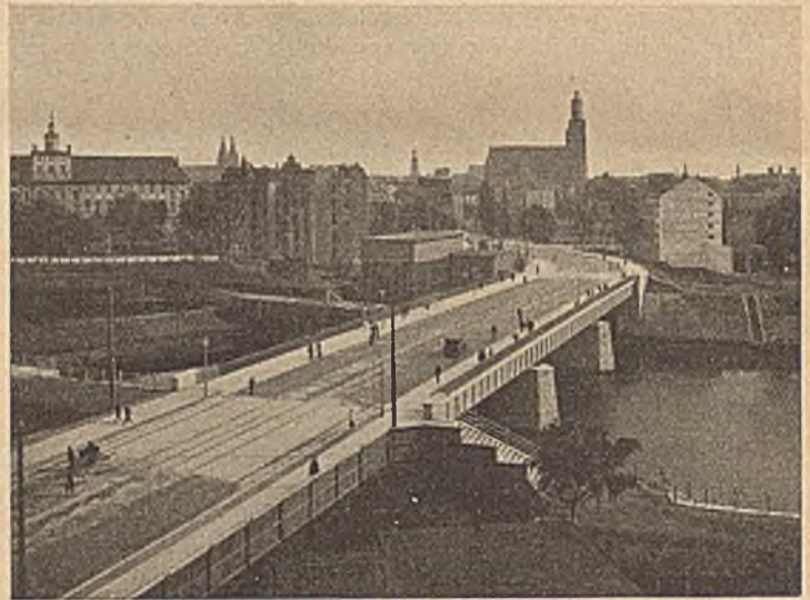
Abb. 11. Blick auf die Brücke vom rechten Ufer.
