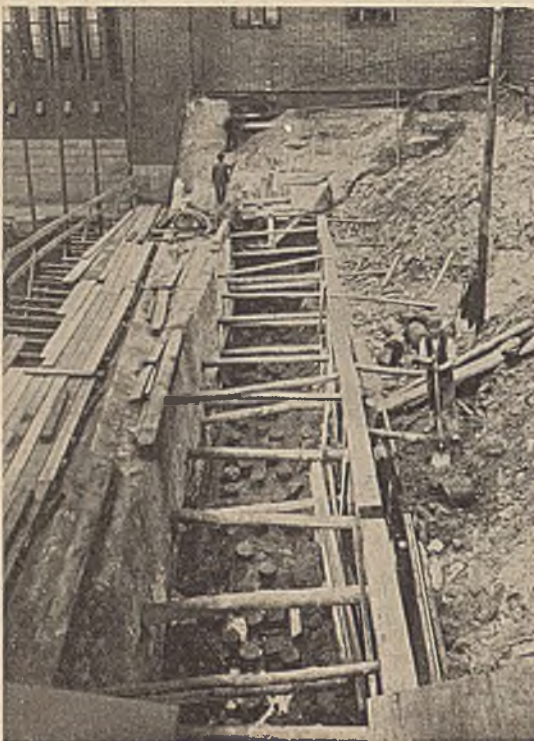
Abb. 4. Rammschlitz für das linke Widerlager der Brücke.
