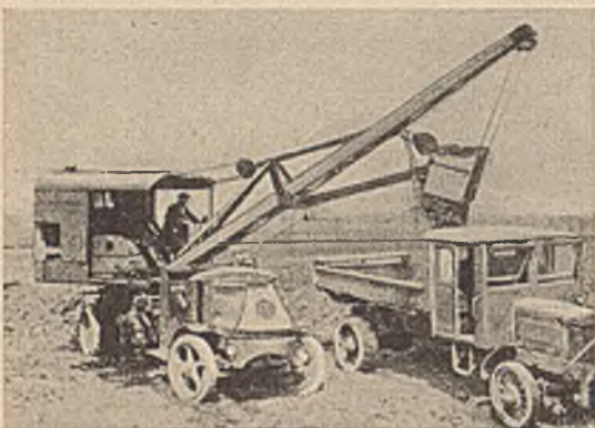
Abb. 4. Amerikanischer Automobilkran mit Löffelbagger.
