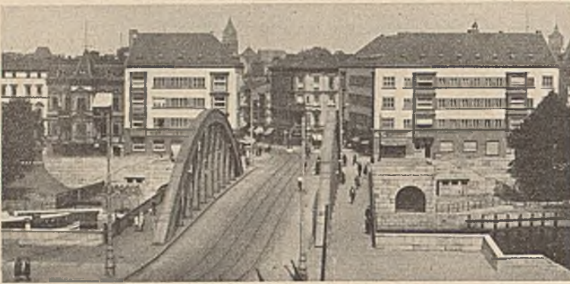
Abb. 10. Charlottenbrücke über die Havel in Berlin-Spandau. Ansicht der neuen Brücke (neue Häuser).
