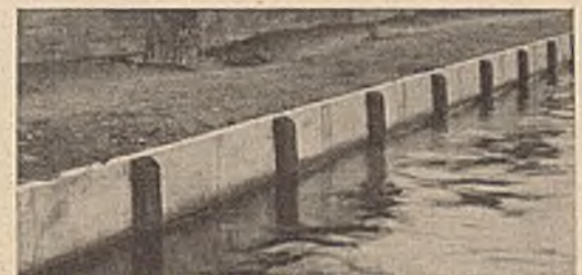
Abb. 4. Ansicht des fertigen Deckwerks.
