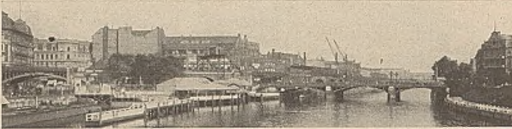
Abb. 23. Neubau der Jannowitzbrücke Berlin und des Reichsbahnviaduktes am Bahnhof „Jannowitzbrücke“. Alter Zustand.
