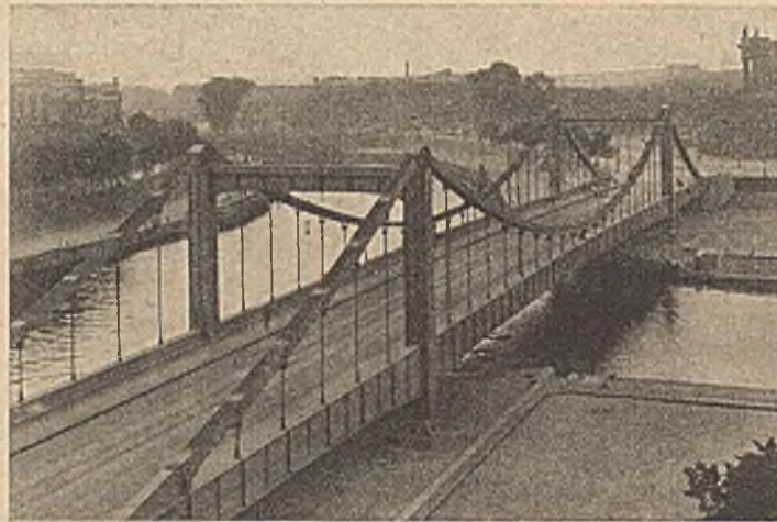
Abb. 18. Brücke über den Humboldthafen in Berlin-Mitte. Neuer Zustand.
