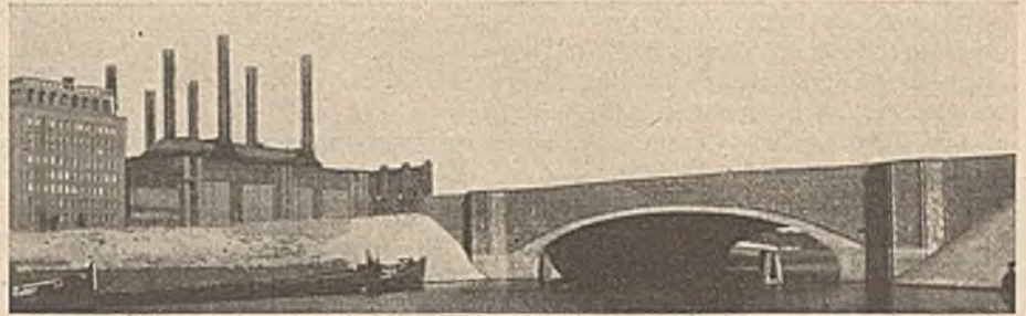
Abb. 26. Brücke beim Großkraftwerk Klingenberg.
