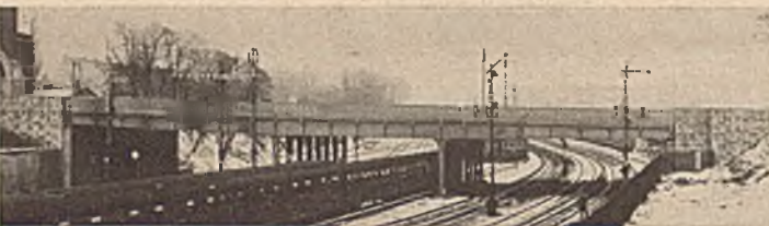
Abb. 38. Knobelsdorffbrücke über die Ringbahn in Berlin-Charlottenburg. — Neue Brücke.
