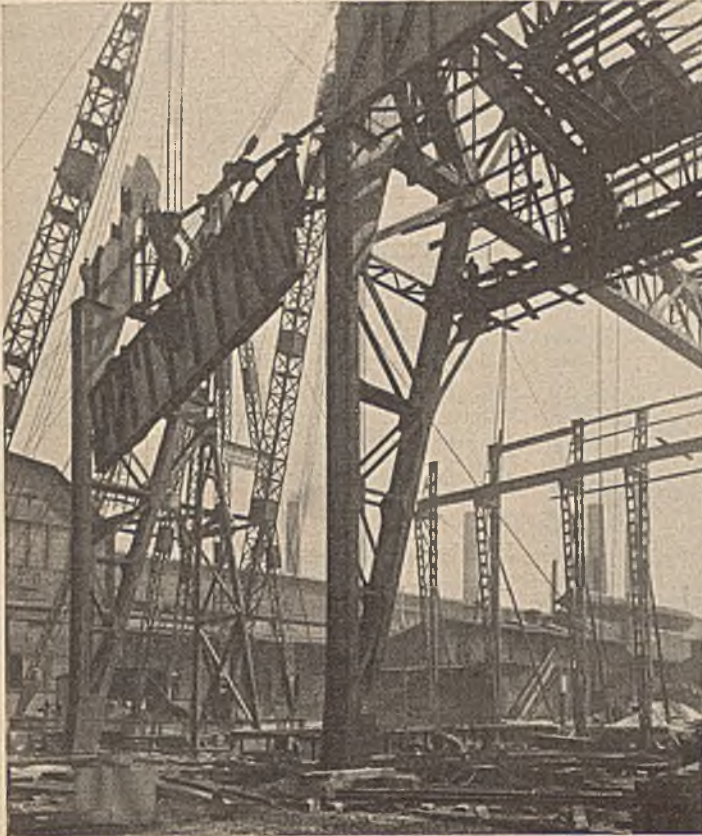
Abb. 8. Hochziehen eines Kranbahnträgers der 300-Tonnen-Krane.
