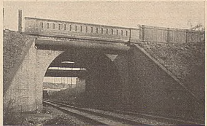
Abb. 40. Straßenüberführung 901 a (Kronprinzendamm) in Berlin-Charlottenburg-Wilmersdorf. — Alte Brücke.
