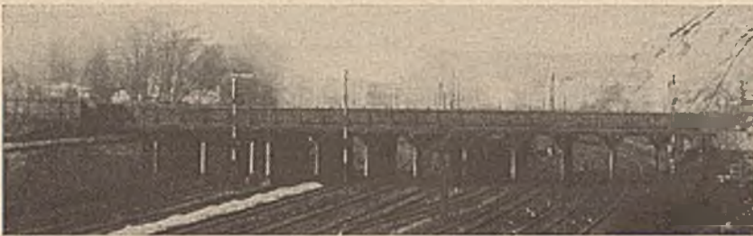
Abb. 37. Knobelsdorffbrücke über die Ringbahn in Berlin-Charlottenburg. Alte hölzerne Brücke.
