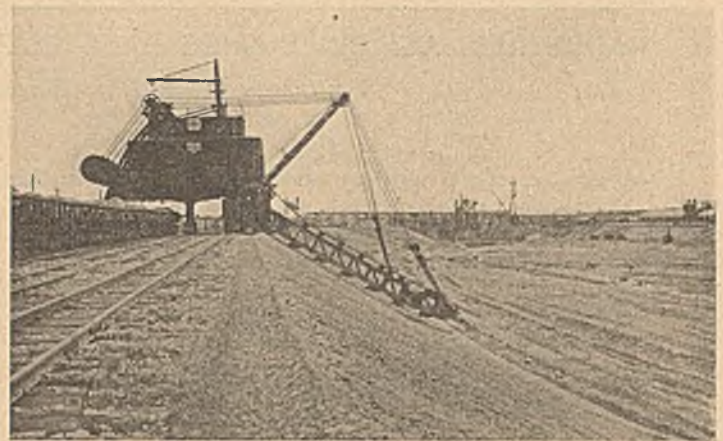
Abb. 3. Großbagger der Lübecker Maschinenbau-Gesellschaft Type N. D. 1.
