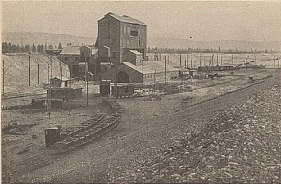
Abb. 8. Blick in das Kanalbett mit Beton-Aufbereitungsanlage.
