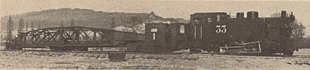
Abb. 7. Schwere Gleisrückmaschine zum Rücken des Baggergleises.
