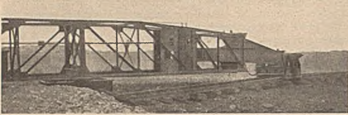
Abb. 6. Gleisrückmaschine. Die Abbildung zeigt die Hebemaschine im Begriff, das Gleis auf das neue Bankett zu legen.
