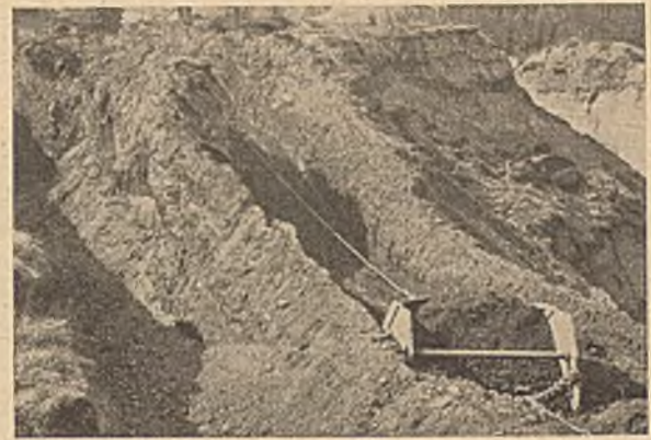
Abb. 2. Die Arbeitsweise des Schrappers (Hasenlever) in einer Sandgrube zur Beseitigung der Abraumschicht und Gewinnung des Sandes.
