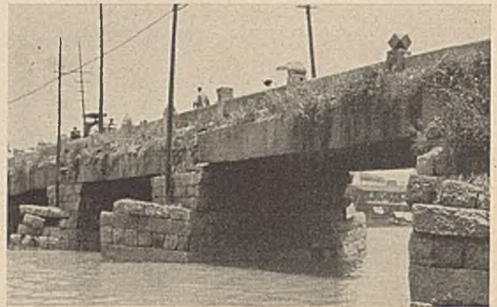
Abb. 6. Steinbalkenbrücke in Futschau.
