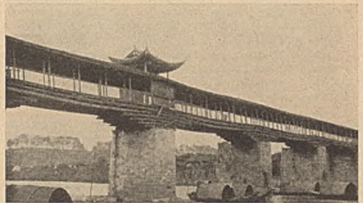
Abb. 3. Brücke über den Kien-yang in der Provinz Fukien.
