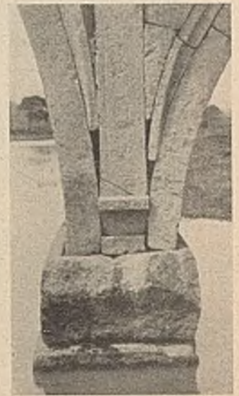
Abb. 10. Zwischenpfeiler der in Abb. 9 gezeigten Brücke.
