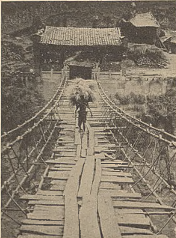
Abb. 13. Blick auf die Fahrbahn der Brücke.
