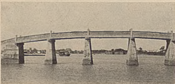
Abb. 5. Brücke über den Kaiserkanal.
