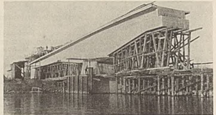
Abb. 11. Ablassen des Lehrgerüsts für den linken Bauteil und Ziehen der abgeschnittenen Spundwände.
