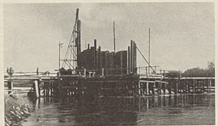
Abb. 8. Fundierung des linken Strompfeilers.
