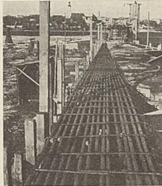
Abb. 10. Draufsicht auf die Hauptträgerbewehrung über dem Strompfeiler.
