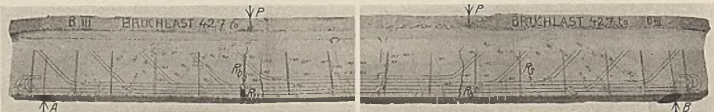
Abb. 2c. Bruchbild von Balken 3.
