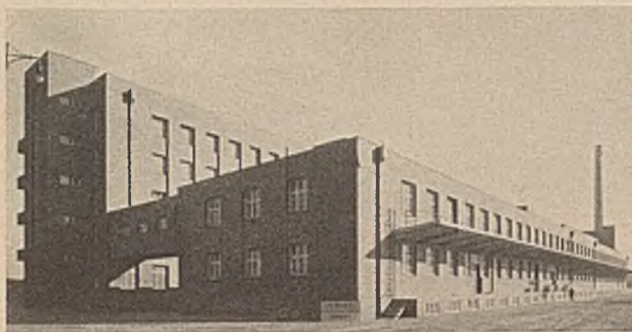
Abb. 9. Neben- und Hauptgebäude mit Verbindungsbrücke vom Hofkanal gesehen.
