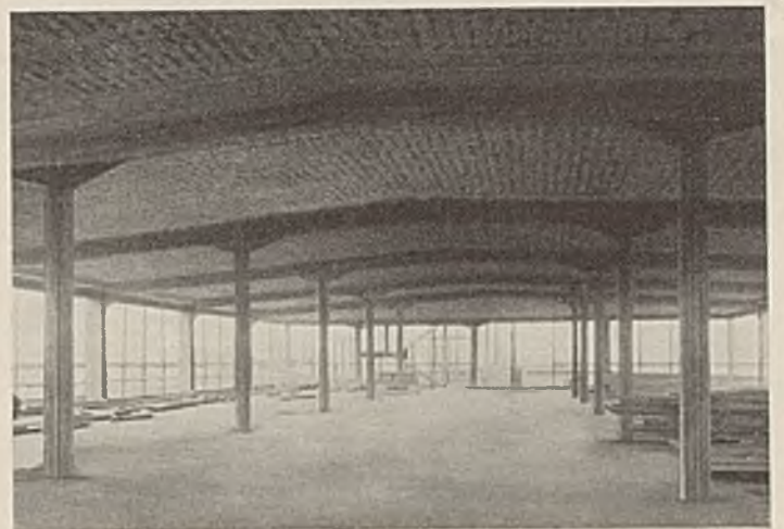
Abb. 4. Ausgeschaltetes Dachgeschoß im Hauptgebäude.
