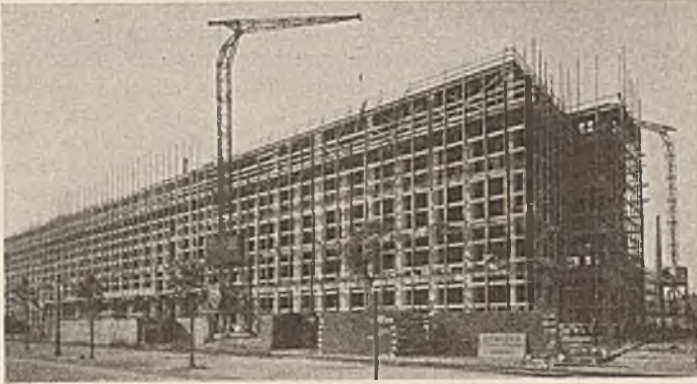
Abb. 5. Ansicht des Eisenbetonskeletts von der Peutestraße gesehen. (Hauptgebäude bis einschl. IV. Obergeschoß.)
