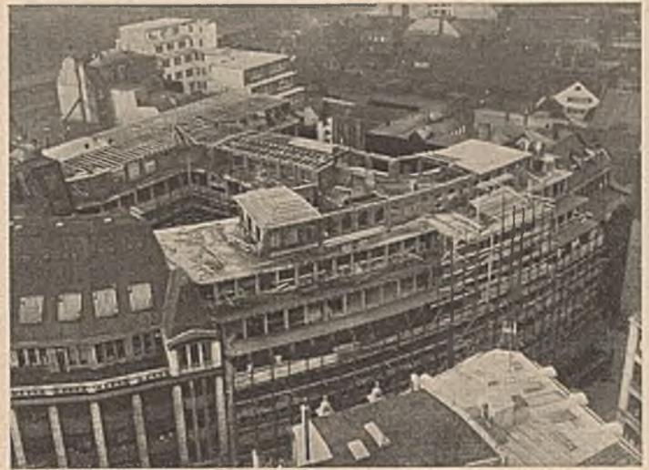
Abb. 15 b. Mauerwerk und Dach des 8. Obergeschosses. (Fertigstellung der Betonarbeiten am 4. XI. 1929.)
