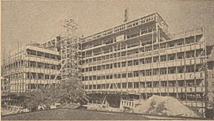
Abb. 20. Bauzustand am 27. VIII. 1930. Ansicht des fertigen Eisenbetongerippes mit teilweiser Ausmauerung.
