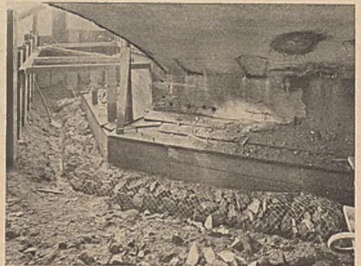
Abb. 13. Fertiges Umschließungsbankett.
