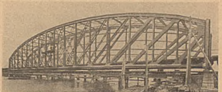
Abb. 21. Verstärkung der Brücke über den Zeggelinstrom. Gesamtansicht mit dem verstärkten Untergurt.
