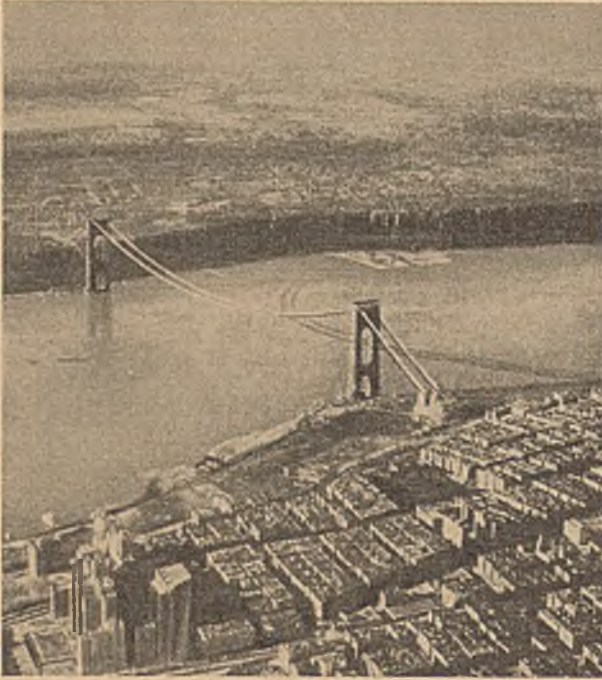
Abb. 1. Ansicht der Fort-Lee-Brücke. (Kabel fertiggestellt, Fahrbahn fehlt noch.)
