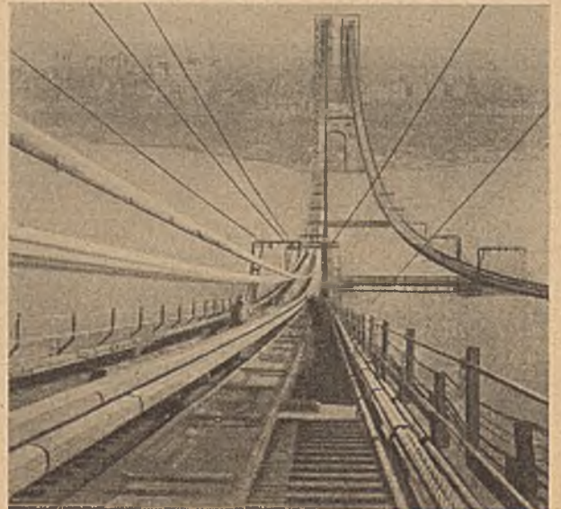
Abb. 3. Hauptöffnung. Beide Kabelpaare mit den Arbeitsbrücken.
