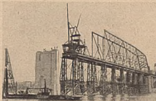
Abb. 4. Aufstellung des Tragwerkes der östlichen Stromöffnung.
