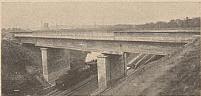
Abb. 6. Nordansicht. Blick nach Witten.
