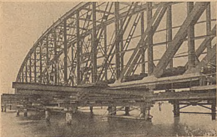
Abb. 19. Verstärkung der Brücke über den Zeggelinstrom. Hebelarmträger zur Entlastung des Hauptträgers von Eigengewicht.
