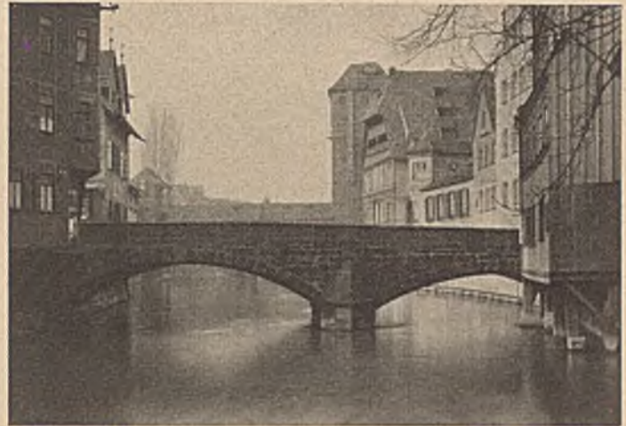
Abb. 15. Oberstromige Ansicht nach dem Umbau.
