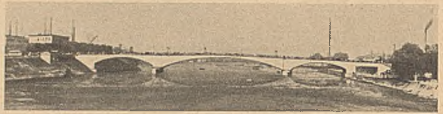
Abb. 30. Ansicht, Standpunkt A.
