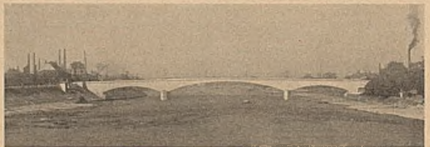
Abb. 43. Ansicht, Standpunkt A.
