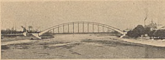
Abb. 40. Ansicht, Standpunkt A.
