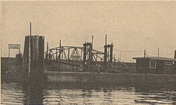
Abb. 1. Gesamtbild der fertigen Anlage.
