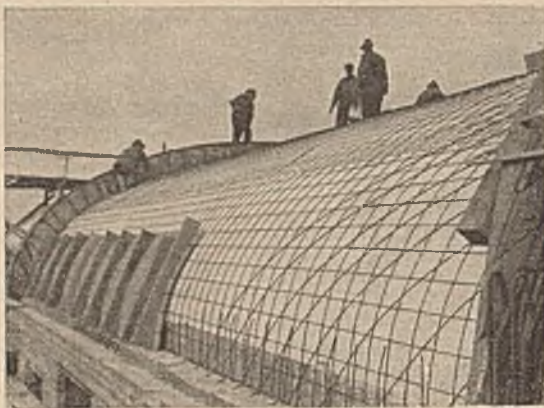
Abb. 7. Die Verlegung der Eisenbewehrung über die Tonnenschalung.
