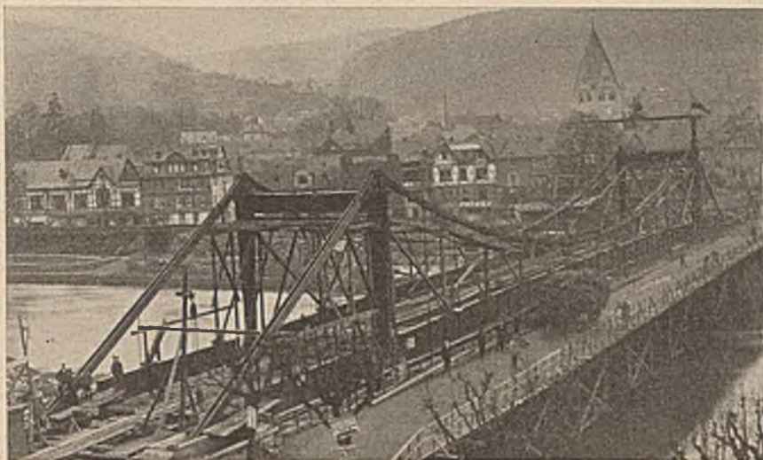
Abb. 3. Bauzustand Ende November 1926
