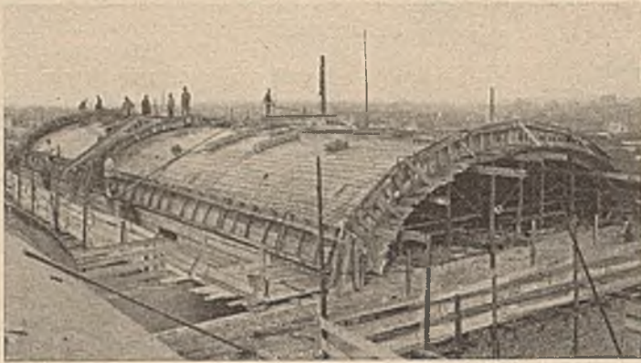
Abb. 6. Einschalung der Tonnen über fester Rüstung.
