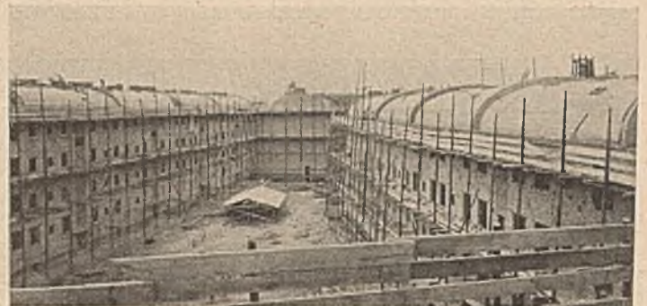
Abb. 8. Blick auf die Dachtonnen nach Vollendung.
