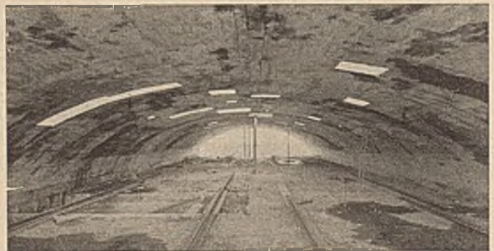
Abb. 9. Blick in das Innere eines fertigen Dachgewölbes.
