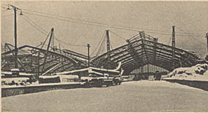
Abb. 13. Bahnsteighallen des neuen Hauptbahnhofes in Königsberg. Zwischenbaustadium.
