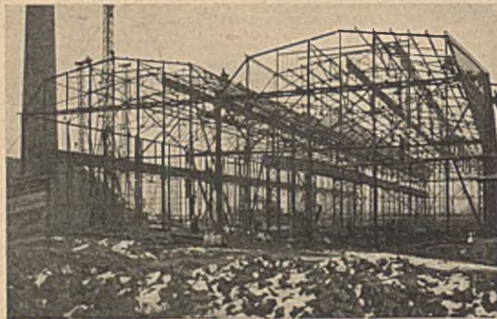
Abb. 11. Doppelschiffige Halle für das Stahlwerk in Ternitz (Österreich). Der fertige Zusammenbau.
