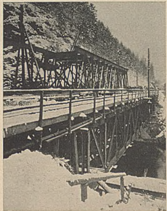
Abb. 18. Auswechslung der Eisenbahnbrücke über den großen Wehrgraben bei Hallstadt (Oberösterreich). Voran das auszuwechselnde Tragwerk, rückwärts die Hilfsbrücke.
