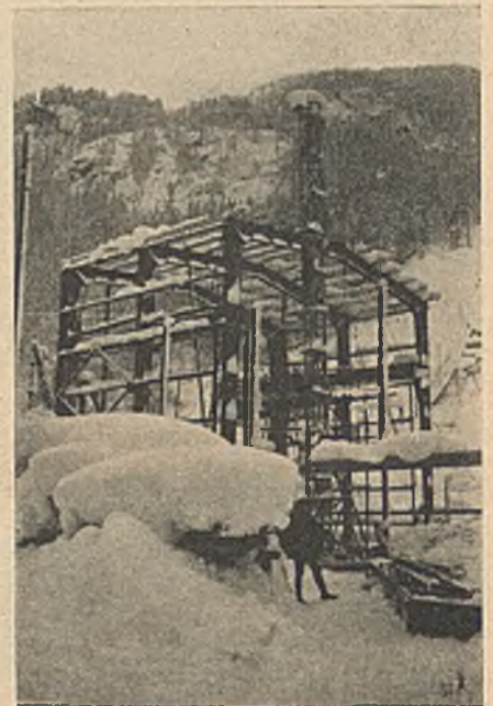
Abb. 12. Krafthaus Parthenen zum Vermuntwerk der Vorarlberger Illwerke A.G. Ausgeschaufelte Transportgasse zum Krafthaus.
