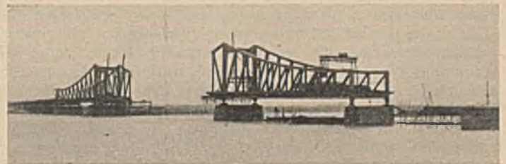
Abb. 20. Rheinbrücke Düsseldorf-Neuß Zustand vor Beginn des freien Vorbauens.
