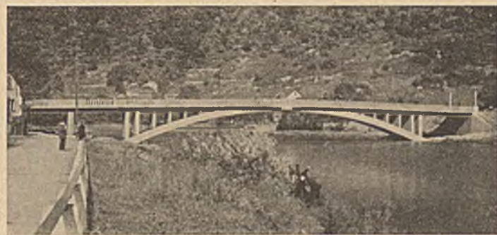
Abb. 2. Eisenbeton-Dreigelenkbogen. Brücke zwischen Nievern und Fachbach.
