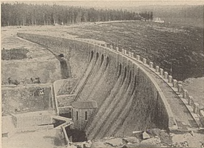
Talsperre Weiterswiese. Luftseitige Ansicht vom Westen gesehen.
