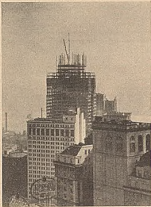
Abb. 3. Baustelle in Detroit mit einem Montage-Derrickkran auf der Spitze und 2 Stockwerken mit Frost-Schutzinhüllung.
