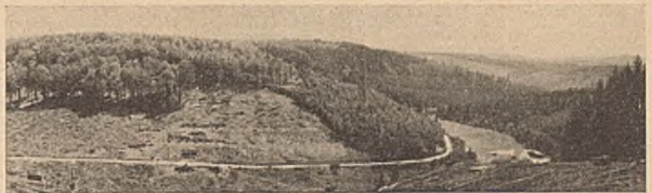
Abb 4. Blick auf die Sperrstelle bei Beginn der Arbeiten.
