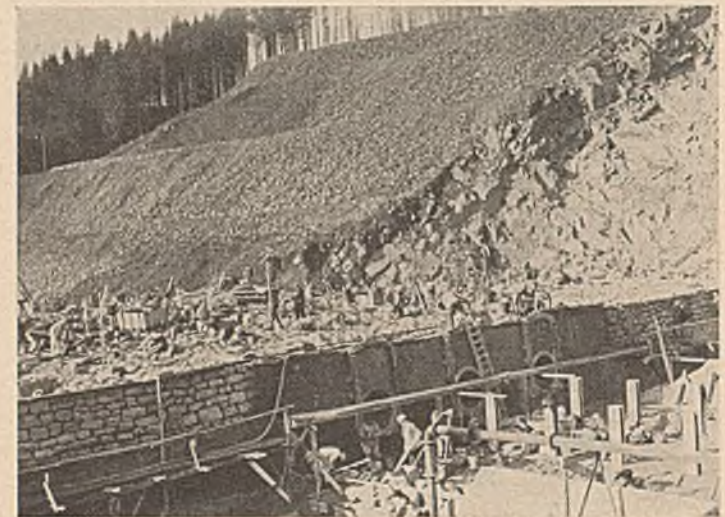
Abb. 16. Blick auf die Sperrmauer von der Wasserseite. Bauzustand Oktober 1930.
