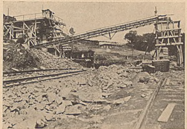
Abb. 13. Großsortier- und Waschanlage.
