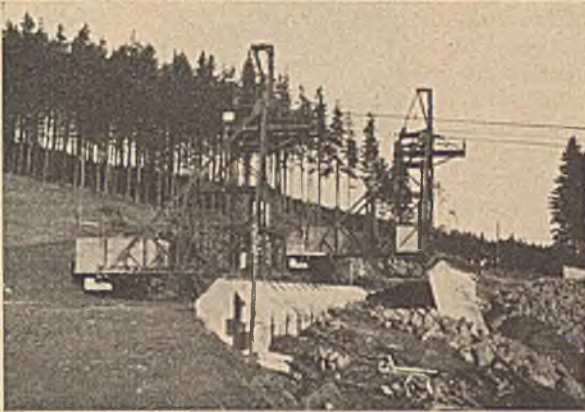
Abb. 12. Die fahrbaren Pendelstützen der Sektorkabelkräne.
