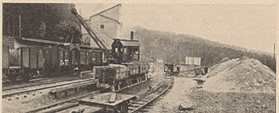
Abb. 6. Anschlußbahnhof mit Bindemittelagern, Vormischanlage und Sandumschlag.
