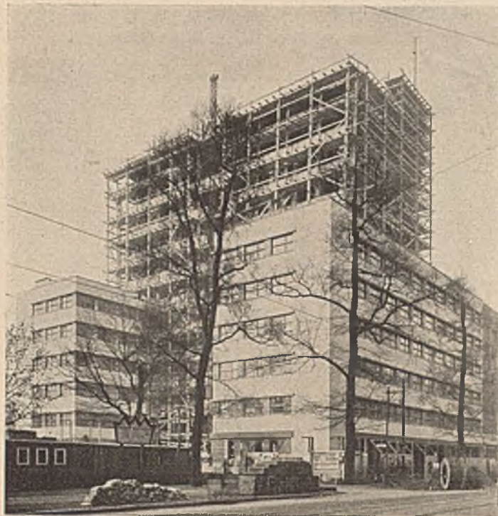
Abb. 13. Kathreiner-Hochhaus, Berlin. Architekt Prof. Bruno Paul. Stahlskelett: Krupp-Druckermüller, Thyssen. Gesamtausführung: Ph. Holzmann A.-G.
