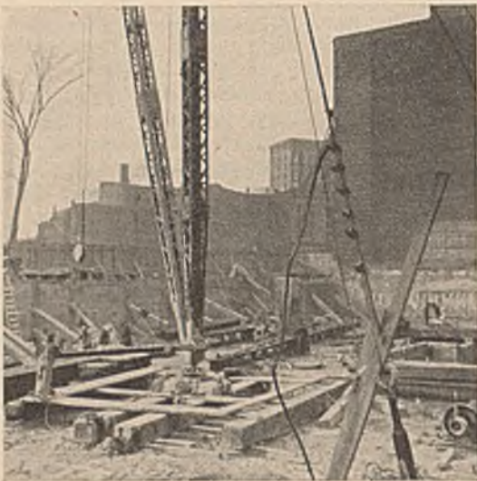
Abb. 1. Montage-Derrickkran, der schon bei der Fundierungsarbeit eingesetzt wurde.
