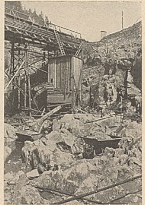
Abb. 15. Baugrube mit Wasserhaltung und Umleitungsrinne. Bauzustand April 1930.
