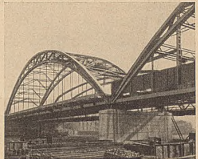
Abb. 2. Ansicht der beiden linksseitigen Bogenträger.
