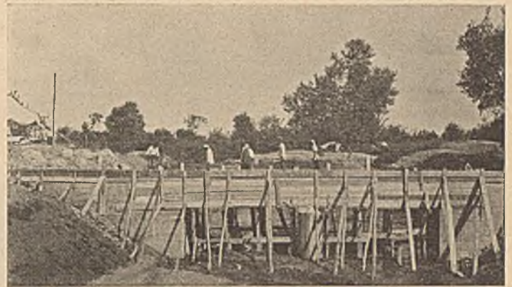
Abb. 9. Darkolarudbrücke in Schalung.
