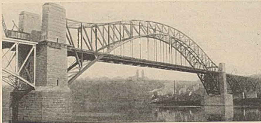
Abb. 4. Ansicht der Stromöffnung.
