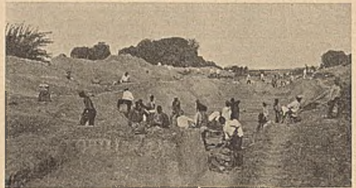
Abb. 5. Erdarbeiten in einem Bahneinschnitt.
