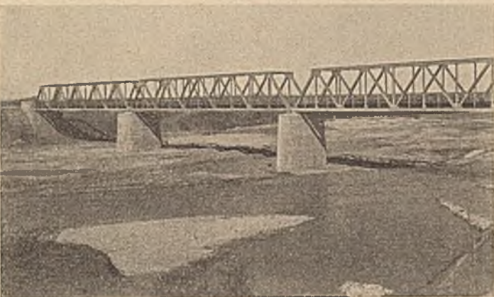
Abb. 8. Tadjenbrücke mit 3 \times 45 m Stützweite.
