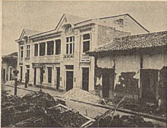
Abb. 11. Garage „Ford“: Die Abschlußmauer über dem Ziegeldach im Vordergrund veranschaulicht die landesübliche „Taquezal“-Bauweise.
