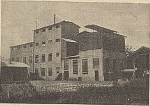
Abb. 10. Teilansicht der Bierbrauerei (Eisenkonstruktion).
