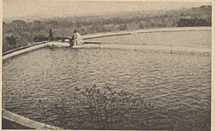
Abb. 12. Der runde Eisenbetonbehälter der Wasserversorgung Managuas.
