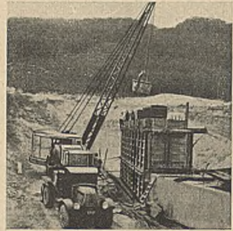
Abb. 2. Ein Abschnitt der Caissonmauer.
